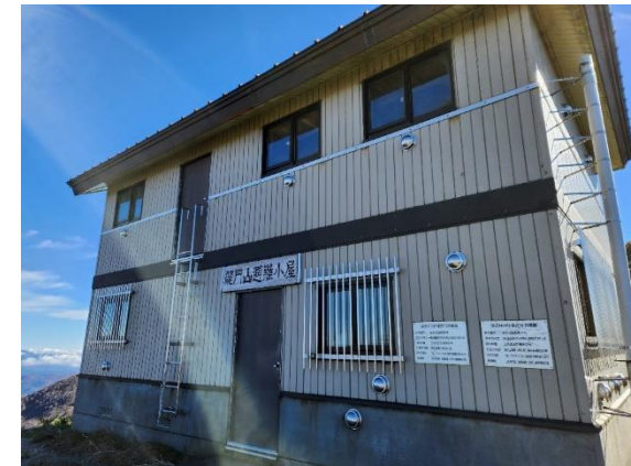
竜門山避難小屋 (上：外觀、下：2階)
